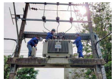
ภาพการติดตั้ง Smart Monitoring Box Set จากข้อตกลงทดลองใช้งานจริง
