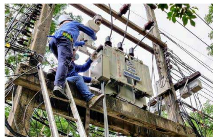
ภาพการติดตั้ง Smart Monitoring Box Set จากข้อตกลงทดลองใช้งานจริง
