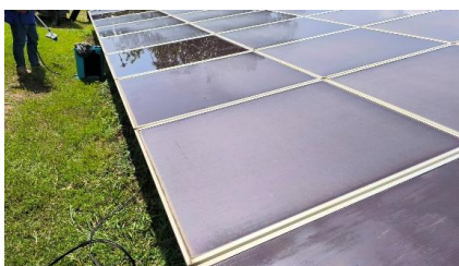
ภาพแสดงแผงโซลาร์เซลล์ที่ได้รับการขจัดคราบตะกรัน และพื้นที่โรงไฟฟ้า Q Solar 1
