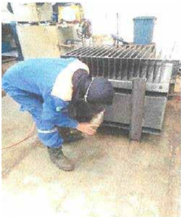
สภาพก่อนปรับปรุง
